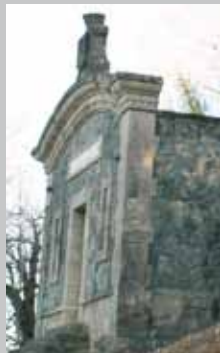
Le réservoir d'eau de Combenègre
